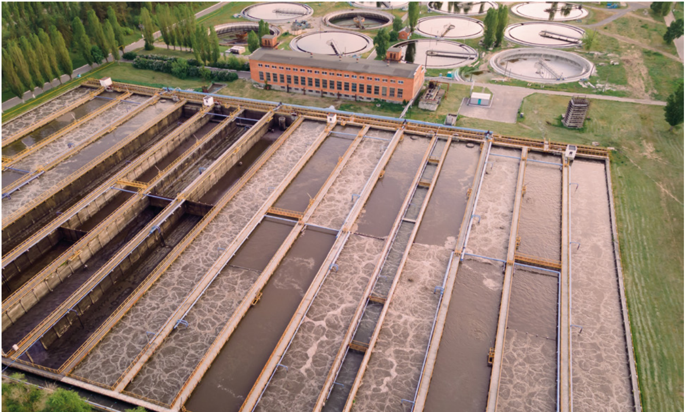
Planta de tratamiento de aguas residuales. Foto: Shutterstock.
