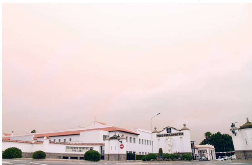
Acceso de la Academia General del Aire de San Javier.
