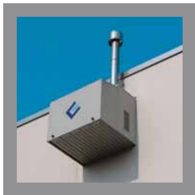
Unidad exterior con conducto de evacuación de humos.
