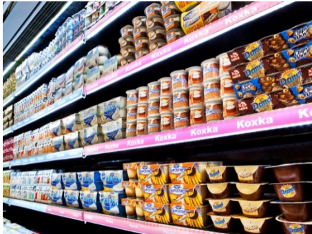
Fig. 5.39. Obsérvese la zona superior izquierda de la vitrina modelo VG9F5814 de la firma Koxka. Se puede apreciar la zona de canalización del aire para la formación de la cortina protector
