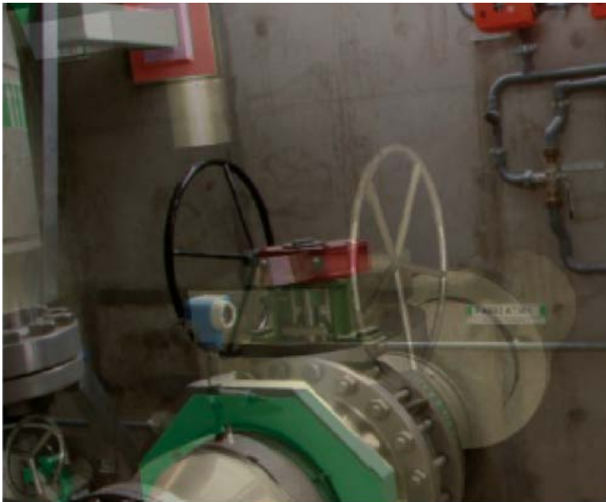
Figura 10. Renderizado del diseño original de la válvula (izquierda) con instalación final (derecha) [11].
