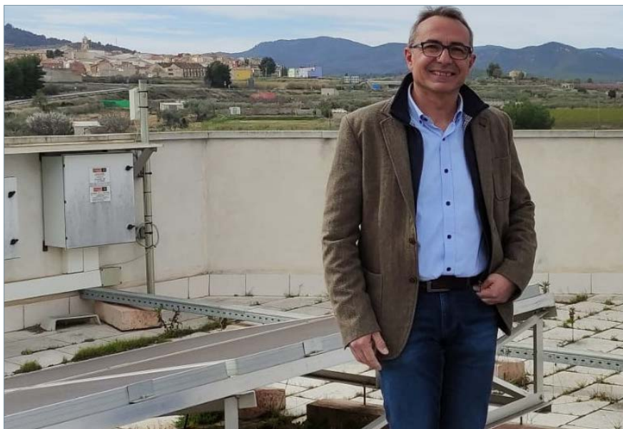
Francisco Espín, junto a la instalación fotovoltaica de autoconsumo instalada en la terraza del edificio donde se ubica su empresa de ingeniería.
