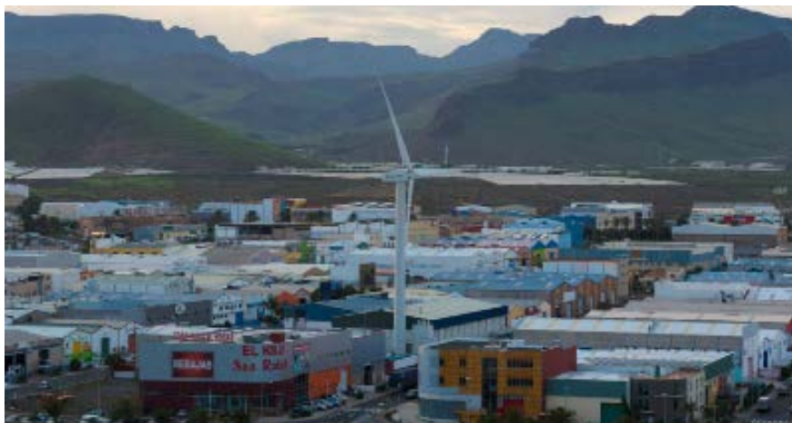
Comunidad energética del Polígono Industrial Arinaga, ubicado en el municipio de Agüimes, en la Isla de Gran Canaria.
