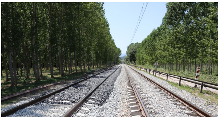
Figura 3. Tramo de pruebas de Neoballast en línea de ADIF entre Caldes y Maçanet Massanes.
